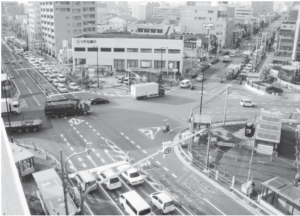
撤去後の様子 (2009.4.6)
