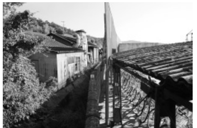
右は中学校の自転車置き場。左の工場の中央には排気ダクト。
